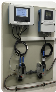
Panely měření volného chlóru
